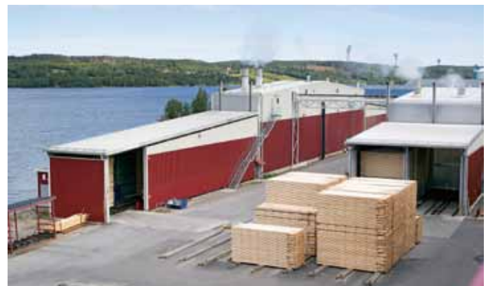
Drei Valutec-Kanaltrockner bei SCA Tunadal – diese Trocknungssysteme erfreuen sich zunehmender Akzeptanz
